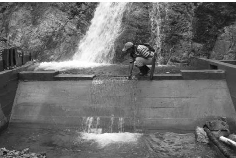
Acueducto Chalguyaco del Municipio de Bolívar, construcción de bocanoma.
