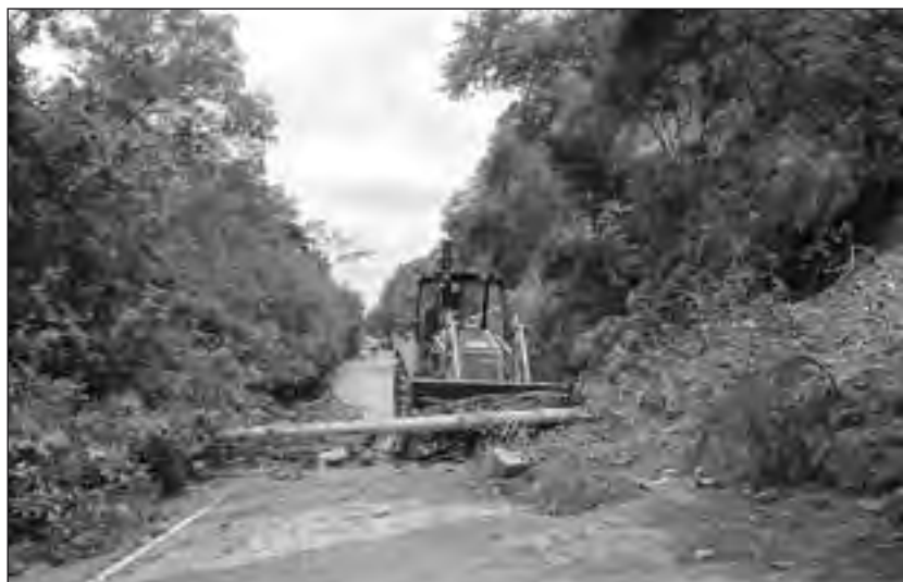
La dura temporada invernal de 2009 obligó a agresivos planes de contingencia como el destaponamiento de vías.
