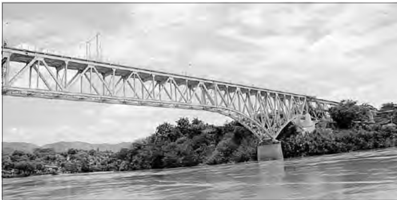
Puente del Ferrocarril sobre el Magdalena, en Girardot. Un símbolo de uno de los principales puertos sobre la arteria fluvial más importante de Colombia.
